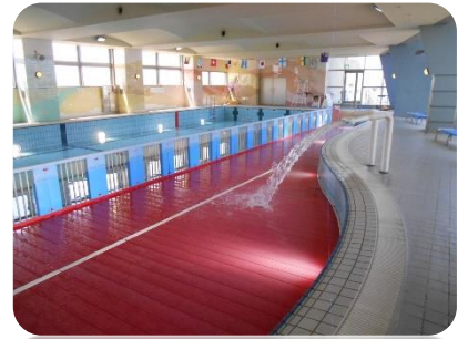
注水作業中のプール
