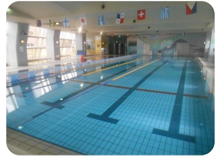
水張り完了後のプール
